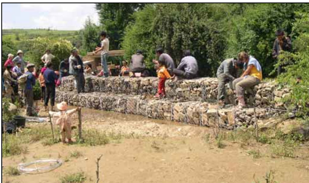
Construction du mur en gabions
