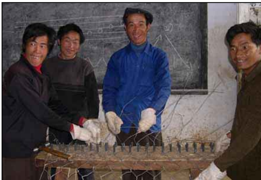
Tressage du grillage nécessaire à la fabrication des gabions
